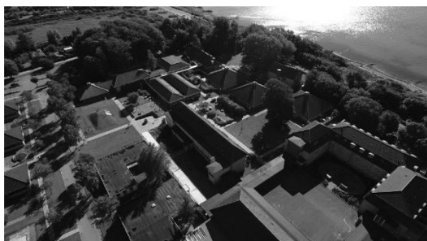
写真4 レフスネス・ビジョンセンター
