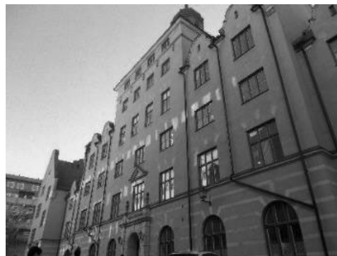
写真 22 スtockホルム県立摂食障害センターの外観 （筆者ら撮影）
